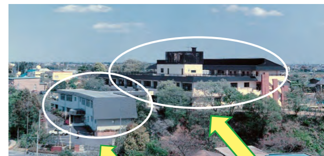
さつき棟の改築
